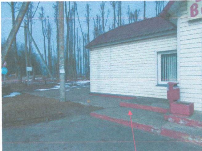
24.03.2021г. Литер а – Покрытие (участок 2)
