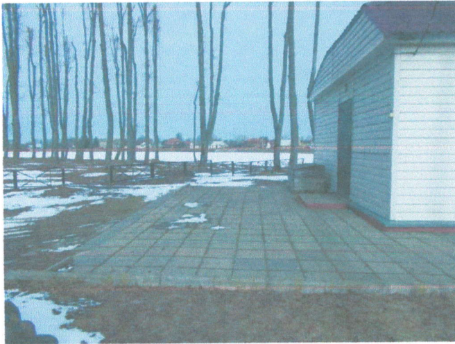
24.03.2021г. Литер а – Покрытие (участок 1)
