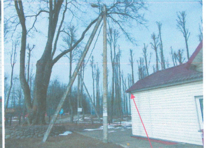
24.03.2021г. Литер б – Сеть электроснабжения
