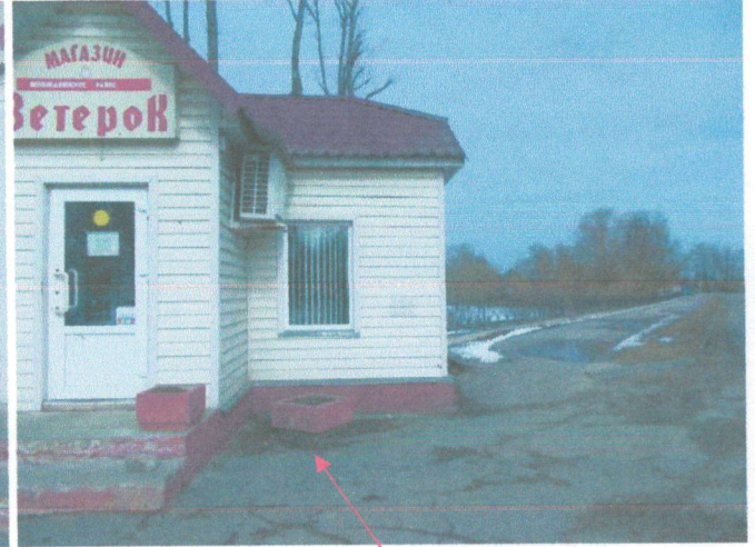
24.03.2021г. Литер а – Покрытие (участок 3)
